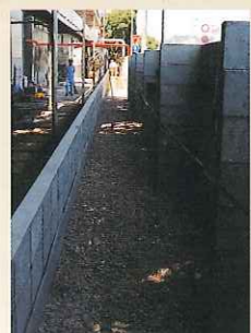
工場外壁の緑地BOX(下に水道管理設)に砂利を敷き排水性を良くするバイオバリアー(1m巾×30m)を水平に敷く
