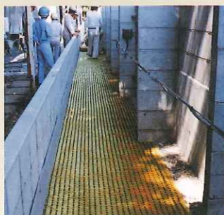
工場外壁の緑地BOX(下に水道管理設)に砂利を敷き排水性を良くするバイオバリアー(1m巾×30m)を水平に敷く
