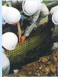
歩道を掘削、バイオバリアーを敷設
