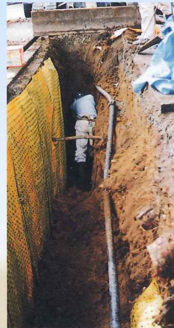
歩道の下に深さ約1.5m、コンボで掘り起こしバイオバリアーを垂直に敷設する
