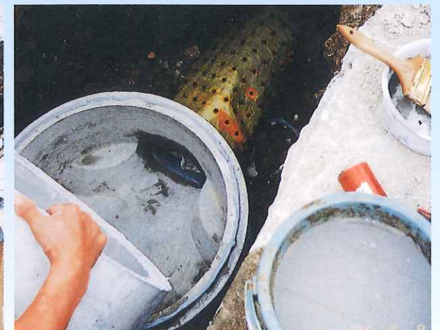
下水道管の排水ピットに接合するジョイント部位に包囲敷設法
